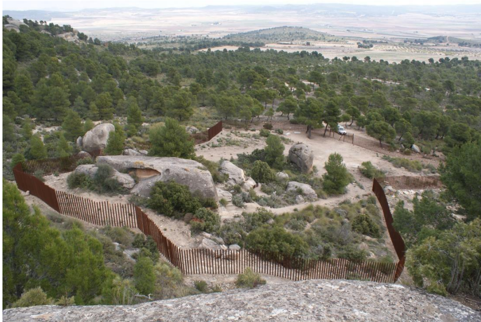
Figura 7 Cerramiento Cantos de Visera. Monte Arabí. Vallado exterior. Foto MAYE
