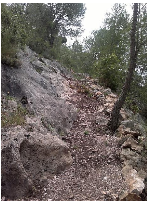
Figura 22 Mejora del camino de acceso
